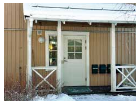
Sländtrissan, Bromma BYGGNADSÅR: 1988
