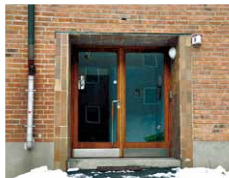
Åbarkpundet-Lästen, Bromma BYGGNADSÅR: 1939–43
