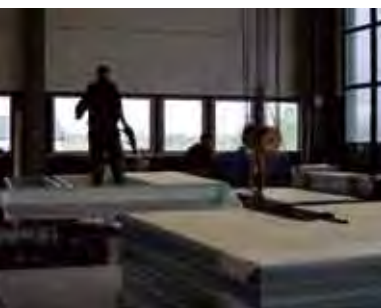
Just nu pågår bygget av kvarteret Marviken för fullt. Här tillverkas väggelement i fabriken i Hedemora.
