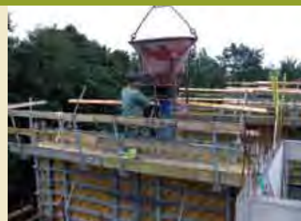
Gjutning pågår i Årsta.
