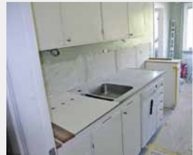
Kök under byggtiden
