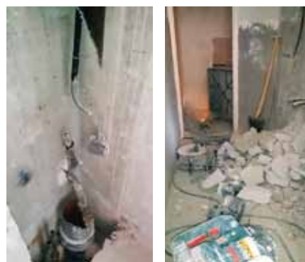
Schakt öppnas och de gamla vatten- och avloppsledningarna tas bort. Rivningsarbetena är både bullriga och dammiga.
