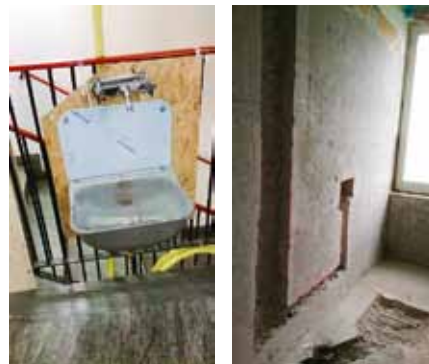
I trapphusen finns vatten att tillgå för de boende. Vid rivningen görs badrummen stomrena och rännor för nytt avlopp och vatten spåras in i konstruktionsbetongen.
