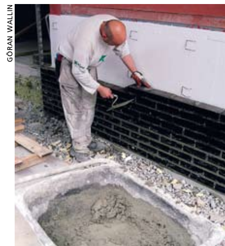
Murningsarbete vid kvarteret Kappseglingen.
