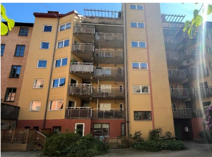
Gårdsfasaden med trapphus och balkonger.
