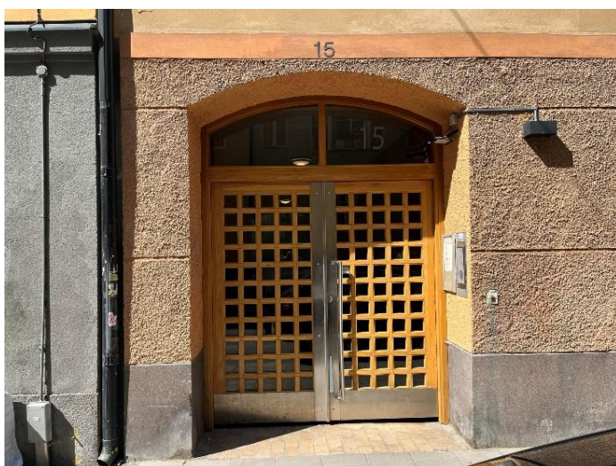
Port som leder till trapphuset och lägenhetsentréerna på gården.
