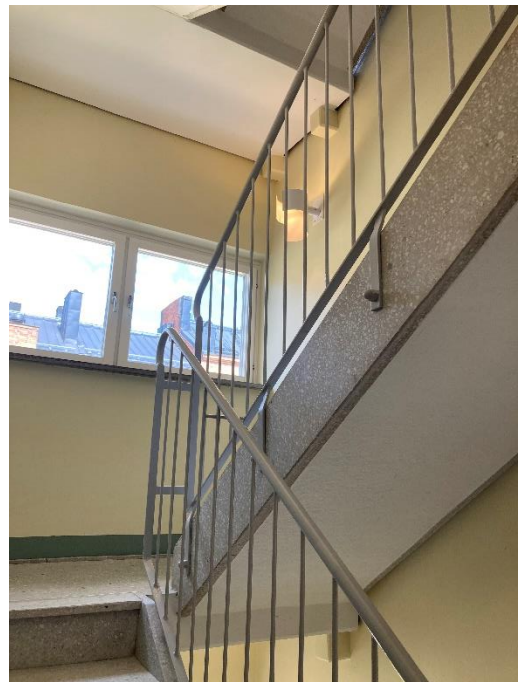
Smalt trapplopp med räcke av lackerat stålräcke, trapplopp och vilplan av ljus terrazzo.
