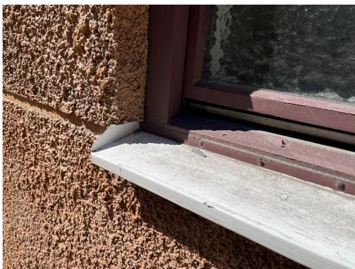
Puts och vitmålade fönsterbleck.
