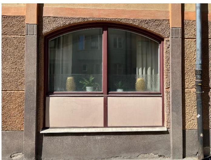
Välvt fönsterparti, bottenvåning mot Skånegatan. Listverk och pilastrar.
