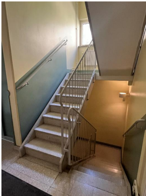
Smalt trapplopp med räcke av lackerat stålräcke, trapplopp och vilplan av ljus terrazzo.
