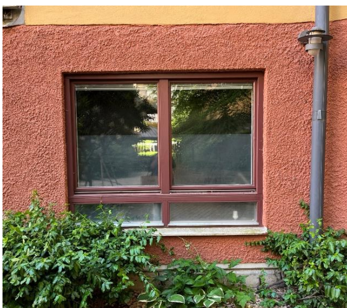
Sockelvåning med spritputs och röda fönstersnickerier. Lyktan passar bra i miljön.
