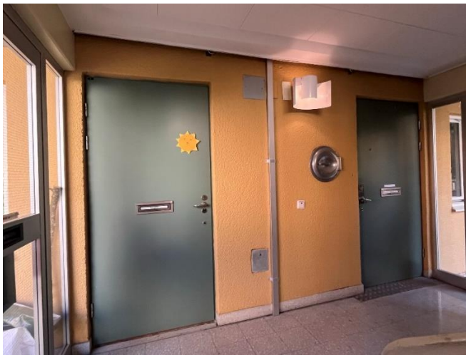
Entrédörrar i trapphuset. Aluminiumpartier till loftgångarna.
